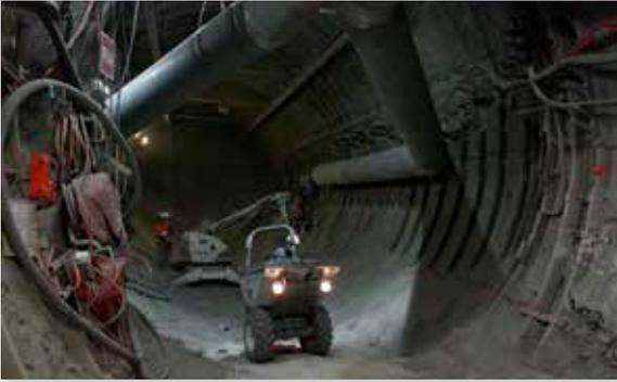
Avant le début du creusement, des forages extensométriques et de mesures de pression ont été mis en place depuis la galerie GRD (Mine by test). Le creusement de la galerie GVA1 a débuté le 5 janvier 2015 et s'est achevé le 9 septembre 2015. Cette galerie a un diamètre de 9 mètres et a été creusée en deux phases : d'abord la calotte (partie supérieure), puis le stross (partie inférieure). Le soutènement est assuré par 51 cintres. Cette galerie a une longueur de 39 mètres.
